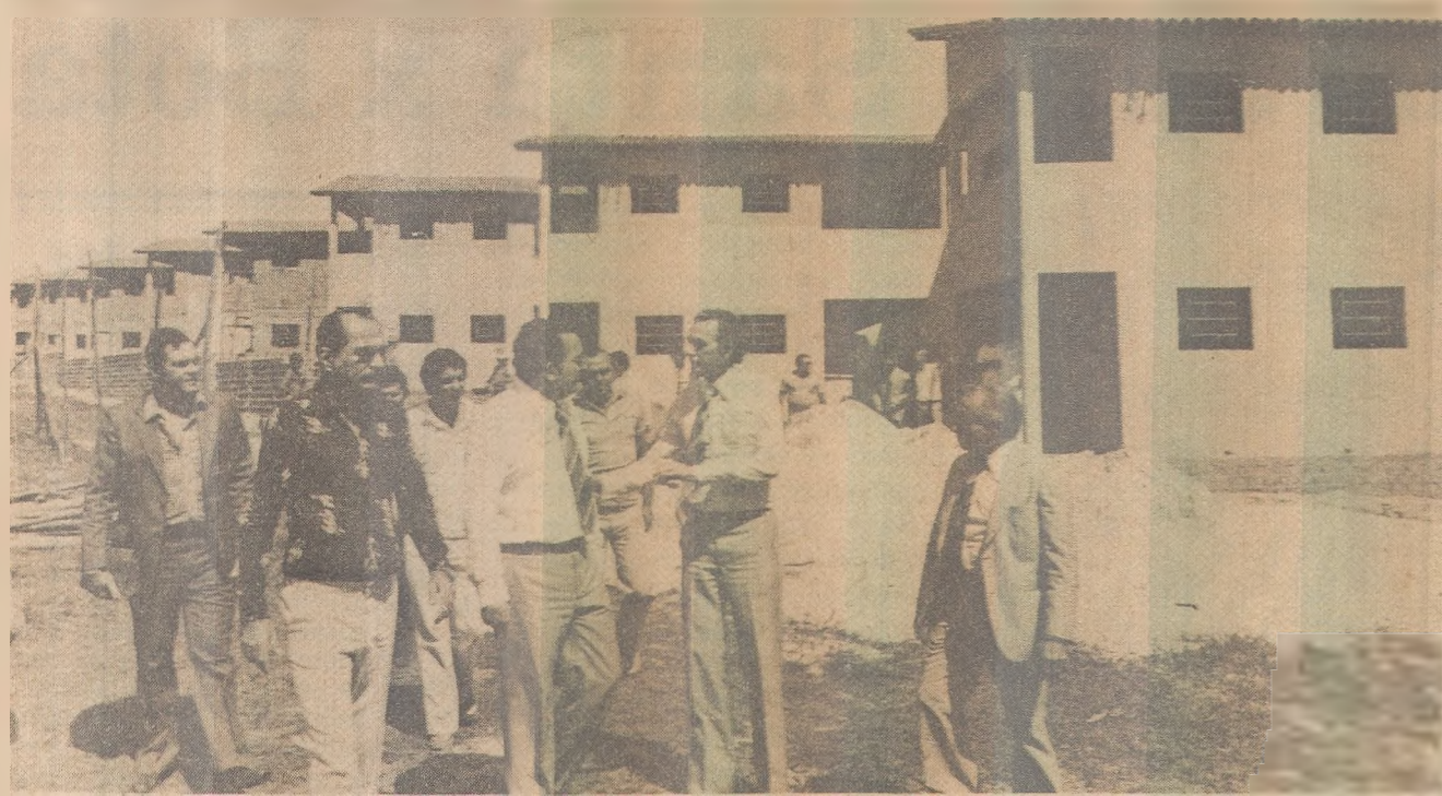
As obras dos conjuntos incluem toda a infra-estrutura básica, como água, energia, esgotos e ruas calçadas.
