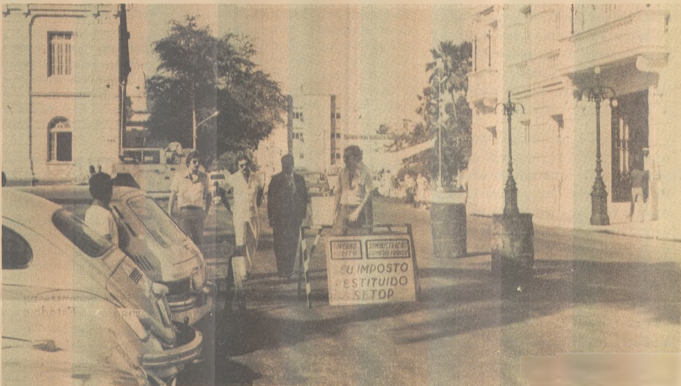
A Prefeitura Municipal terminou ontem com os serviços realizados na Praça João Pessoa, onde estão localizados os três poderes, Palácio da Redenção sede do executivo, Assembléia Legislativa e Palácio da
